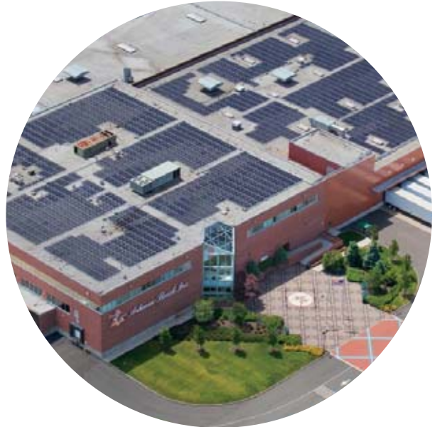
Zonnepanelen in gebruik bij een AB InBev-brouwerij
