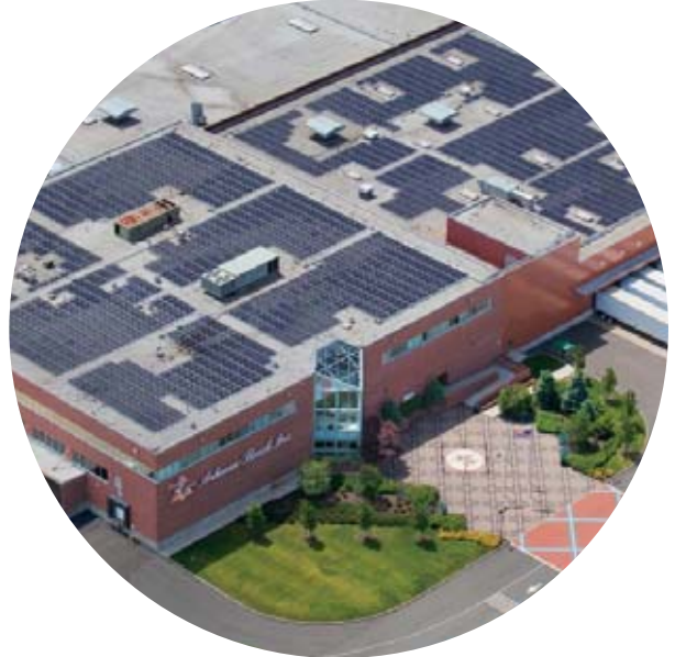
Des panneaux solaires utilisés dans une brasserie AB InBev
